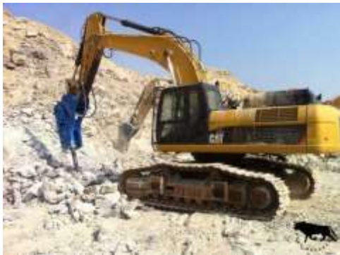
EXCAVADORA (con Martillo Hidráulico)
