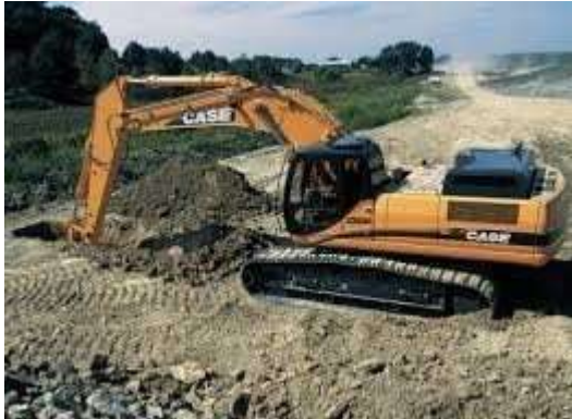
EXCAVADORA SOBRE ORUGA
